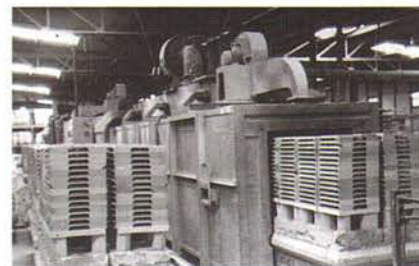
Four tunnel / Печи для обжига
